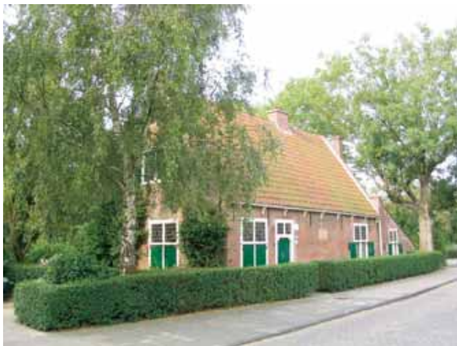
Huset i Rijnsburg.
